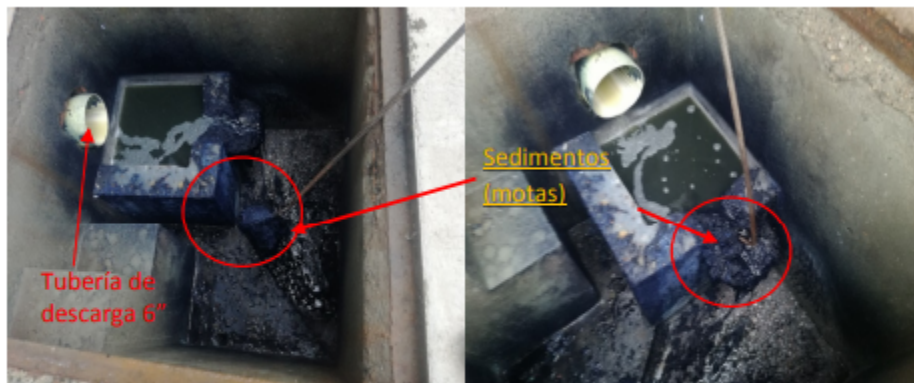
Foto No. 5. Caja de inspección Calle 10 40-07; evidencia de vertimientos y sedimentos del proceso.
