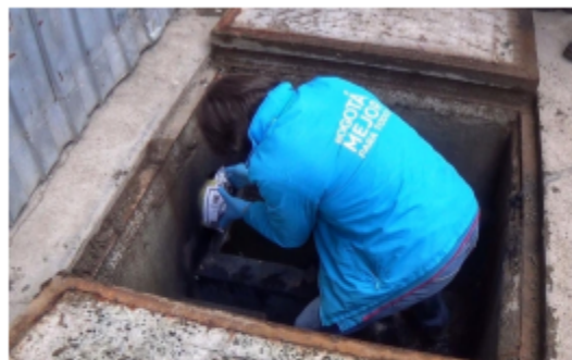
Foto No. 7. Imposición de sellos al punto de descarga en la caja de inspección externa sobre la Calle 10.
